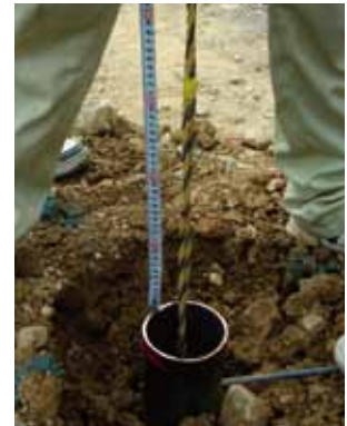
落下高さ確認
